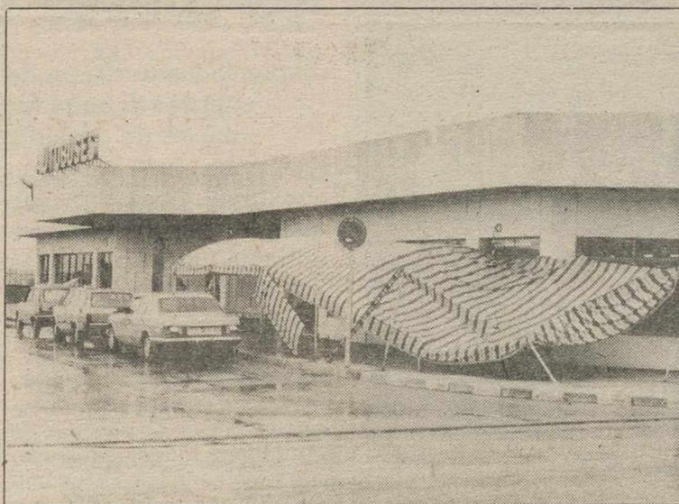
El toldo de la Estación de Autobuses, derribado por el viento.
