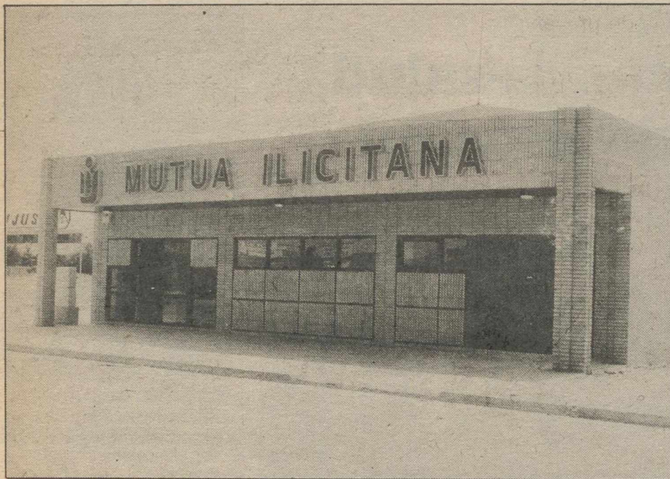
Las instalaciones de Mutua Ilicitana en el Polígono de Campollano.
