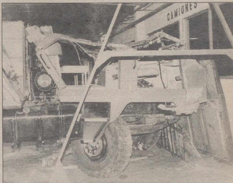
Estado en que quedó el camión.
