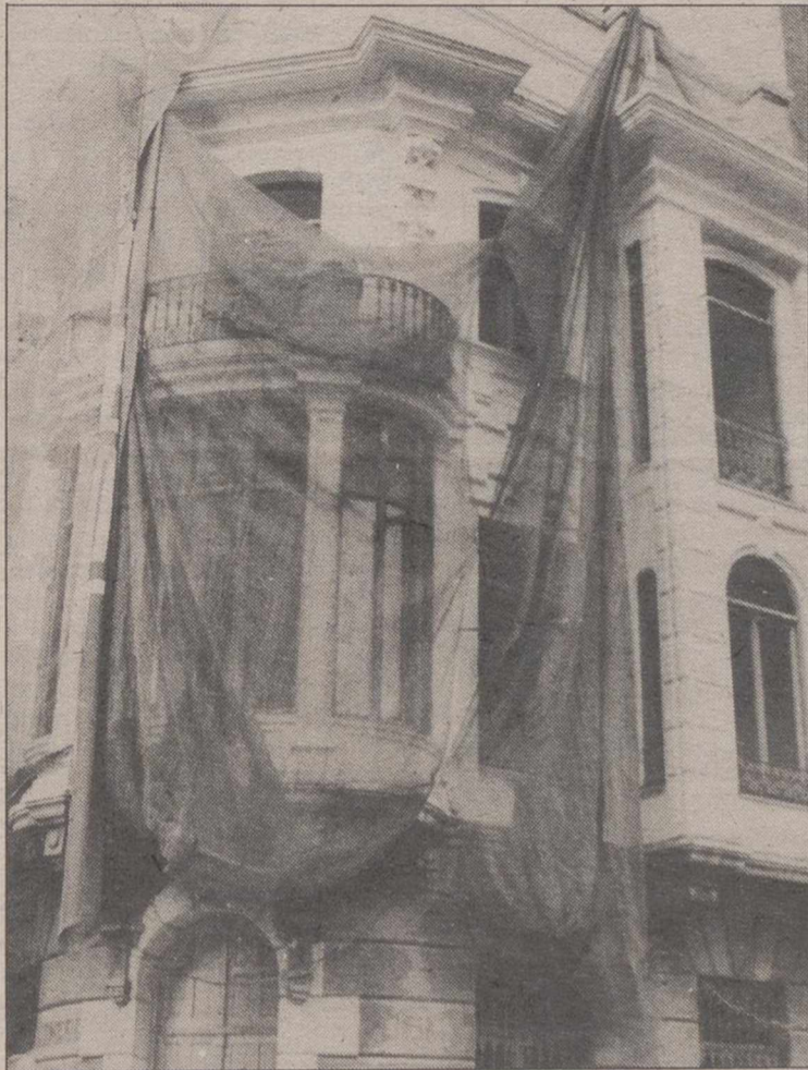
La restauración casi a punto.
