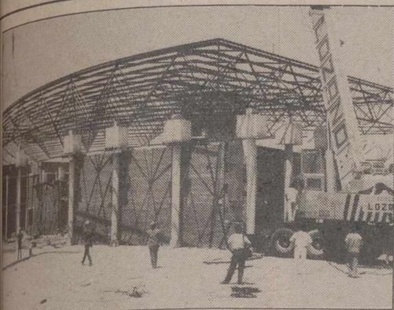
La estructura quedó instalada a las dos de la tarde.
