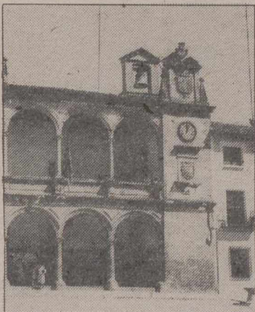
Las obras de la Plaza de Ramón y Cajal impidieron la instalación de las casetas de librerías.
