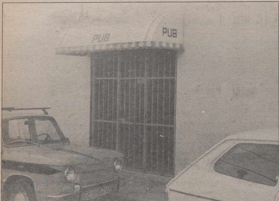
Pub reforzado con puerta de hierro.
