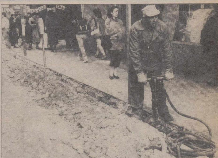
**Obras para la instalación de farolas.** El proyecto de alumbrado público para la zona centro de la ciudad, que pretendía realzar esta parte con la instalación de farolas de estilo clásico, continúa en la calle Ancha. Una primera fase quedó terminada en Navidad en la de Martínez Villena. En la fotografía un obrero realiza las labores de apertura de zanjas por donde discurrirá el tendido eléctrico.
