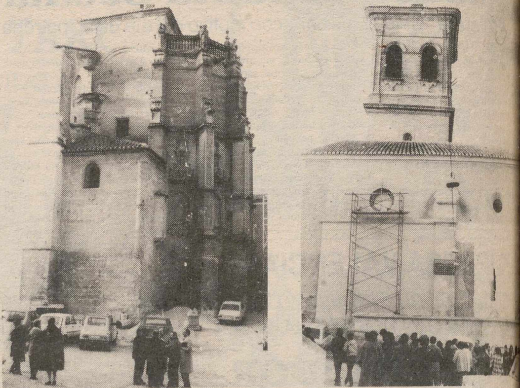
Dos aspectos de la Iglesia de Santa María del Salvador, en la actualidad en período de restauración.
