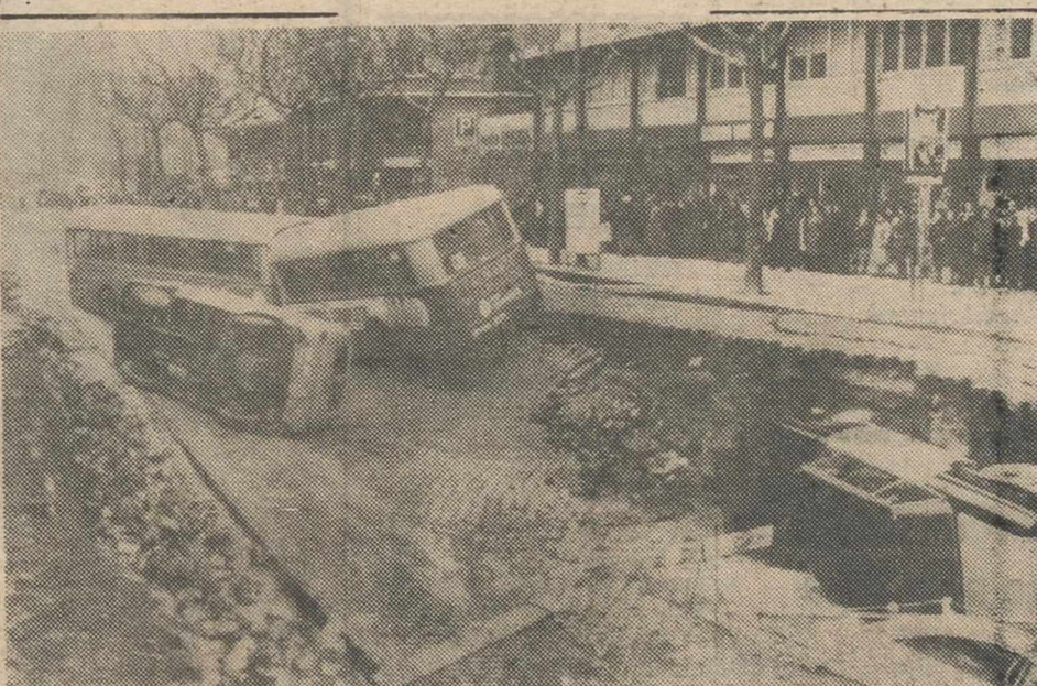
BARCELONA.—Barcelona, es la ciudad de los socavones, cada momento se abre el suelo, estamos los ciudadanos acostumbrados a ello, pero tal magnitud como el de la calle Marqués del Duero que se tragó un autobús articulado, un camión, una furgoneta y varios coches; no, a este tipo de socavones tan impresionante, no.—(Telefoto EUROPA PRESS)
