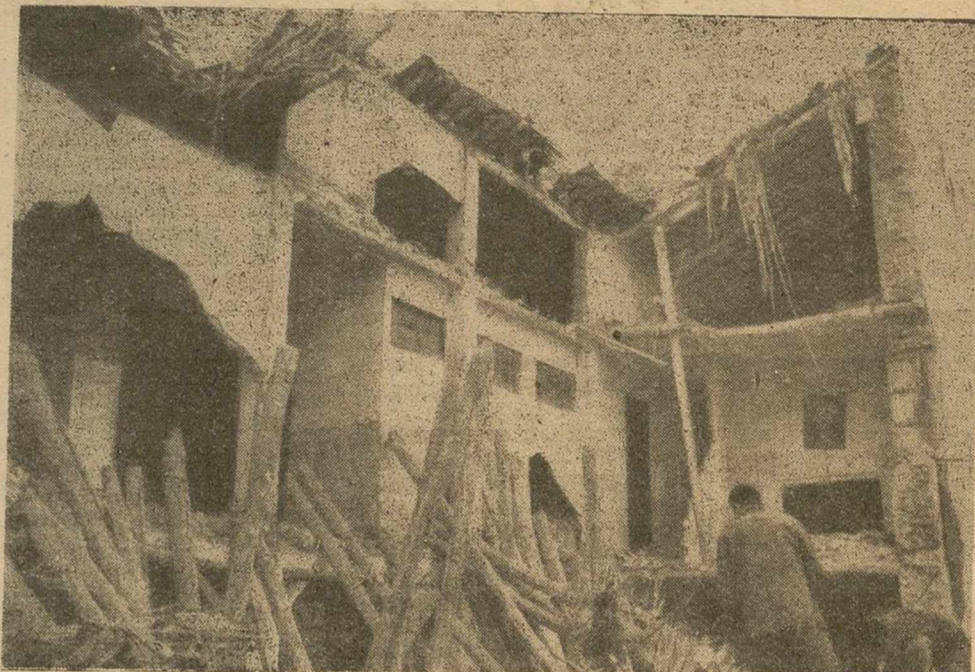
Estado en que quedó la casa hundida esta mañana en la calle de Antonio Rentero
