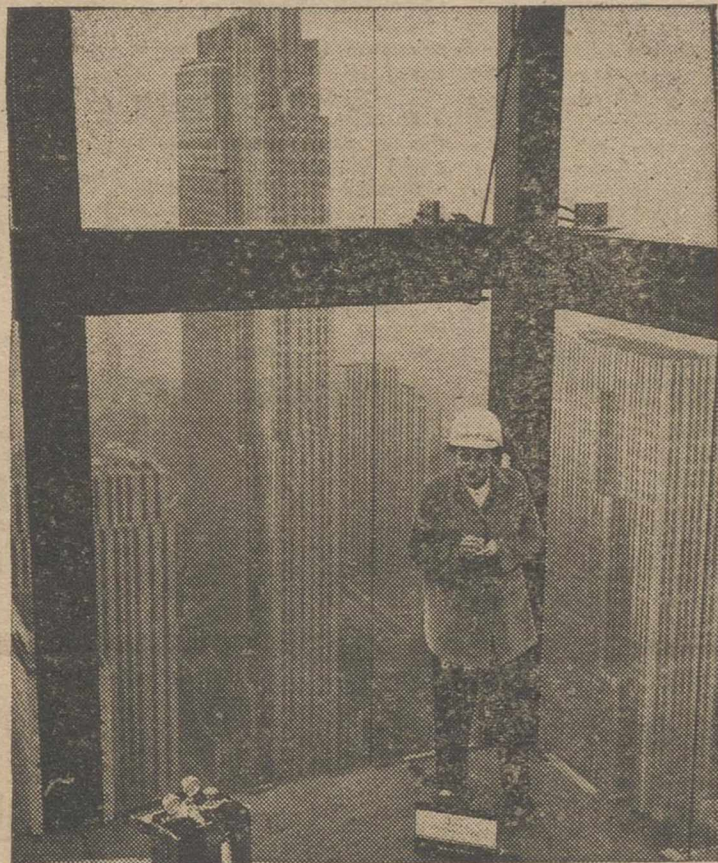
Mrs. Mary Sheehan, enfermera neoyorquina, que ejerce sus funciones en uniforme desacomodado al llegar al trabajo al piso 52 del edificio de la Unión Carbide, en construcción en Park Avenue, en la isla de Manhattan. Empleada por la empresa constructora, Mrs. Sheehan está dispuesta en todo momento a subir al piso 52 o bajar a los sótanos si ocurre algún accidente. Al fondo, el rascacielos del Rockefeller Center.
