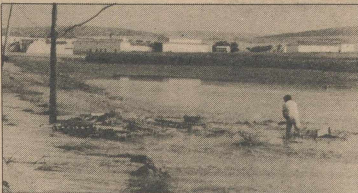
Las riadas e inundaciones han producido cuantiosos daños en Tobarra.
