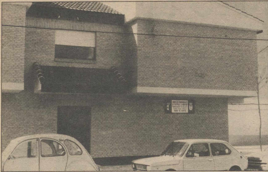
Centro socio-cultural del barrio del Hospital.
