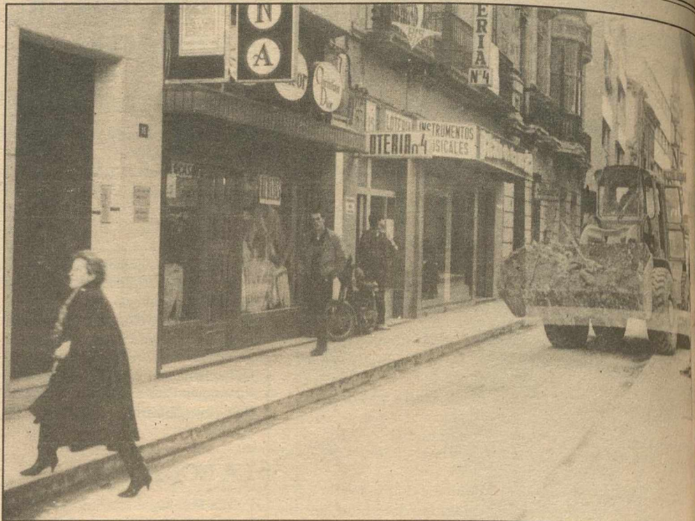
LA CALLE DEL ROSARIO, INTERCEPTADA.—Unas obras en la calle del Rosario, la presencia de maquinaria pesada, interrumpieron ayer el tráfico rodado por la calle del Rosario. Se preguntaban los transeúntes si tales trabajos no sería más conveniente que se realizaran de madrugada. Pero no se sabe qué dirían los vecinos.—(Foto Luis Miguel)
