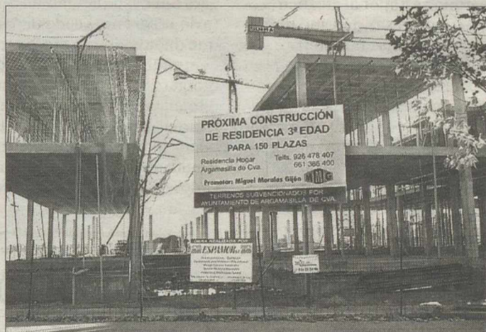
Imagen de las obras. / PILAR G. MANZANARES
