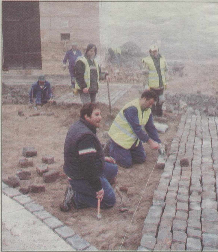
Imagen de las obras que se realizan en la Plaza San Blas de Manzanares. / LT
