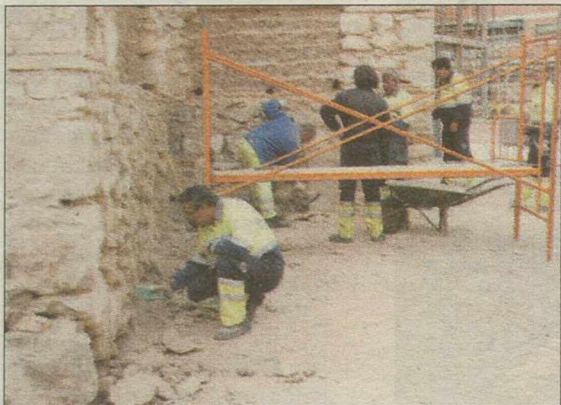
Trabajos en la fachada posterior.
