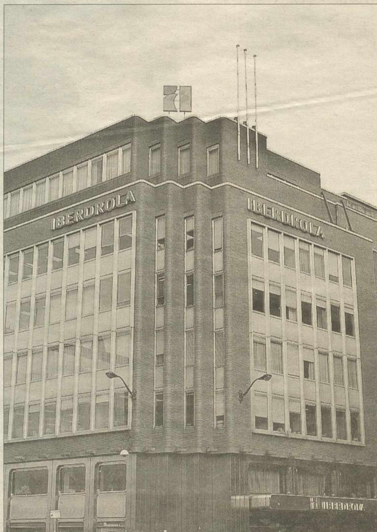
Fachada de la sede de la eléctrica Iberdrola en Bilbao. / TXEMA FERNÁNDEZ (EFE)
