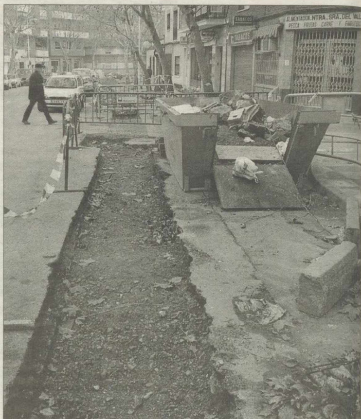
Aspecto de las zanjas de Gran Capitán. /P.G.MANZANARES
