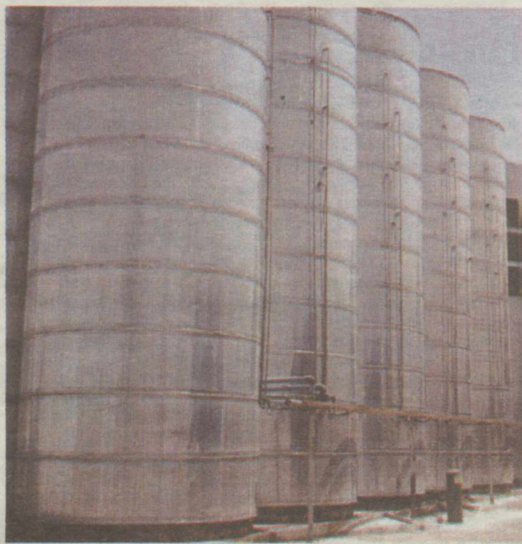
Crisve cuenta con depósito de almacenamiento de distintas capacidades
