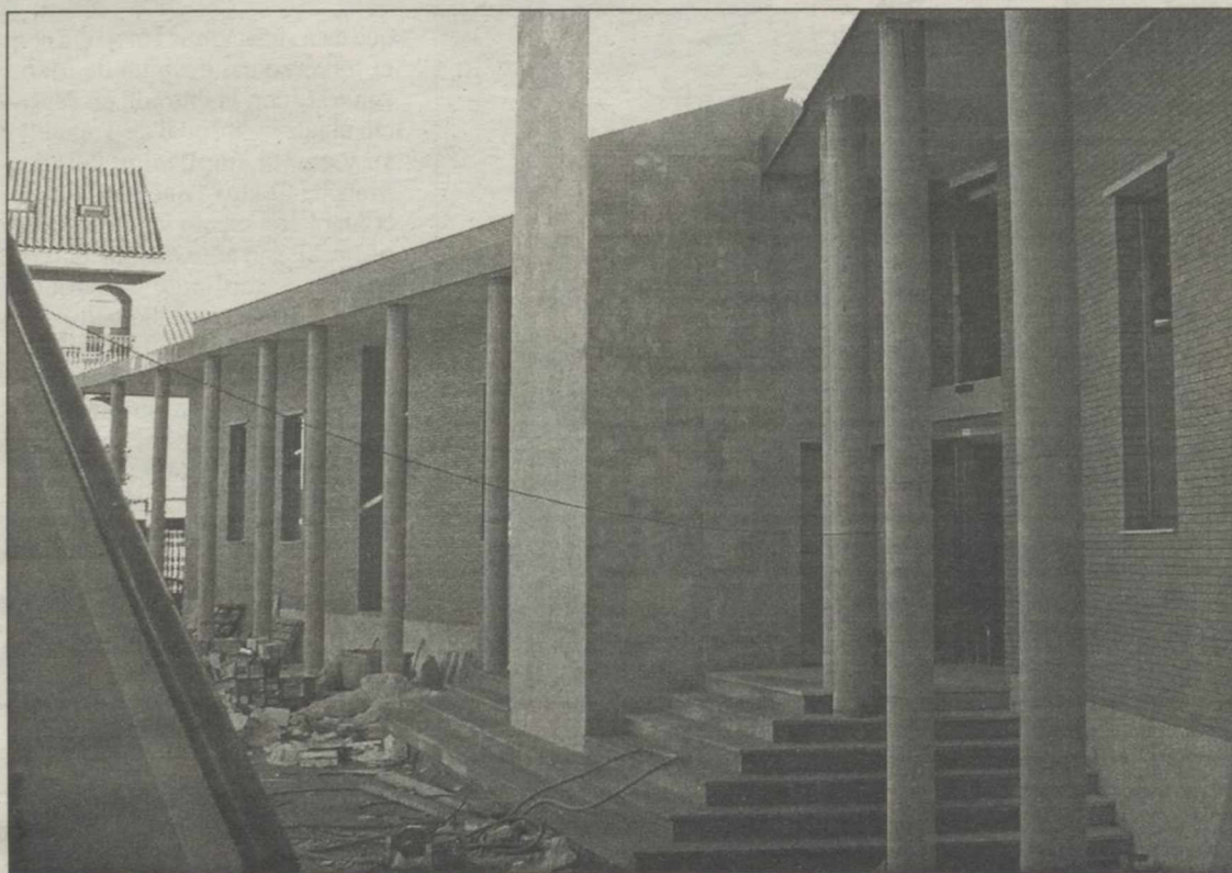
Imagen de las obras del nuevo centro
