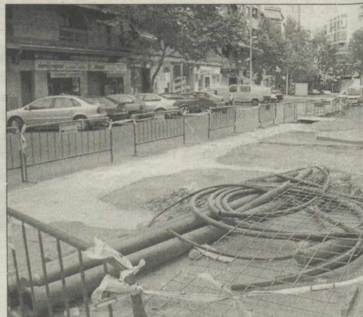
El grosor de la calzada llega a los 80 centímetros
