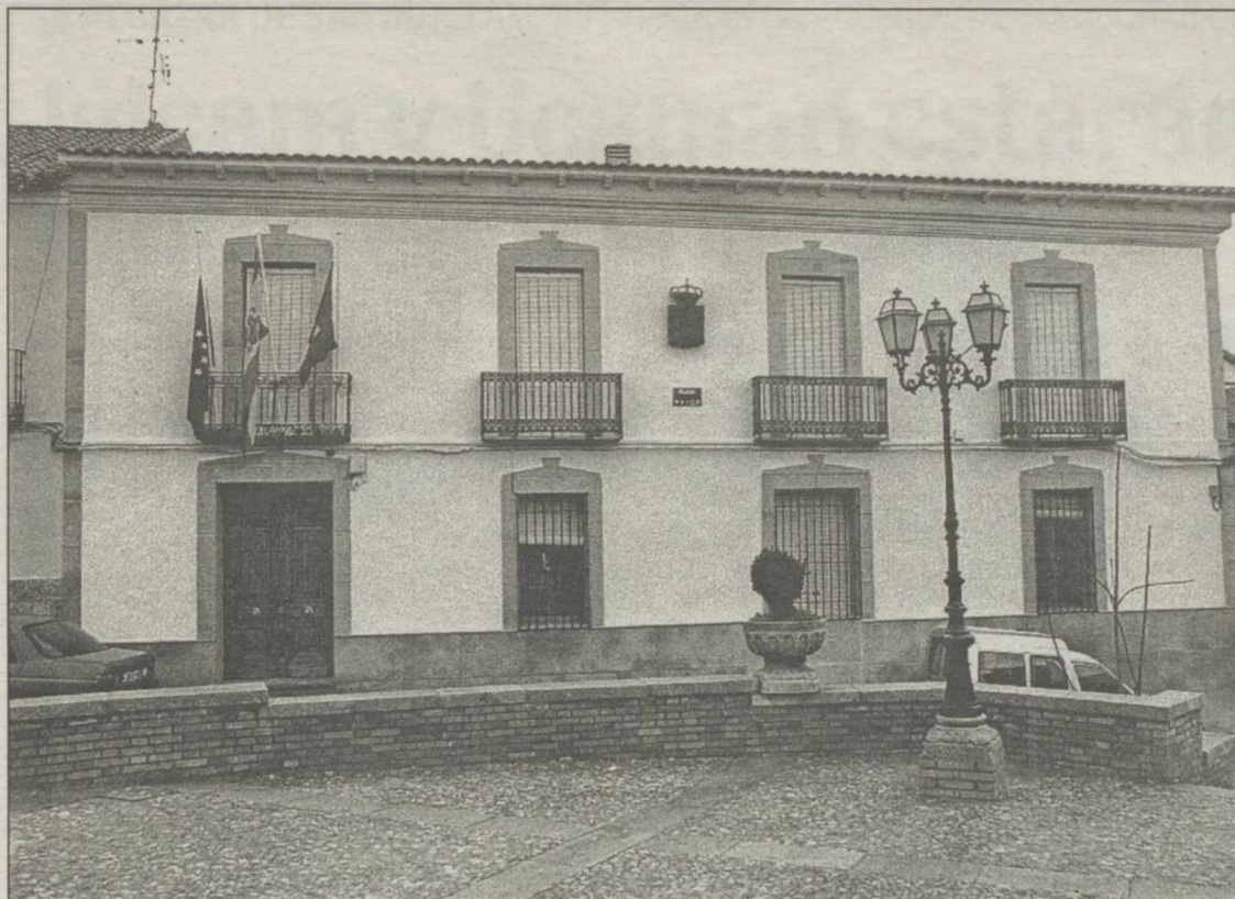
El Ayuntamiento de Piedrabuena continúa eliminando los tendidos eléctricos peligrosos del casco urbano
