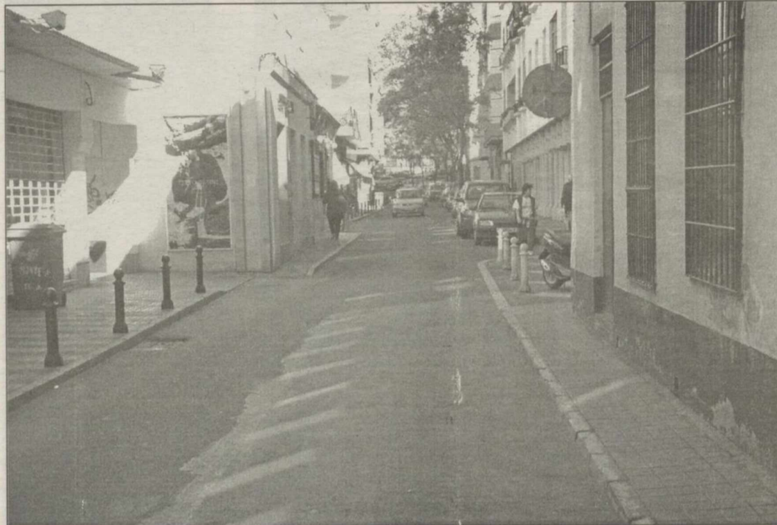
Estado actual de la calle Montesa, una de las vías objeto de reformas próximamente
