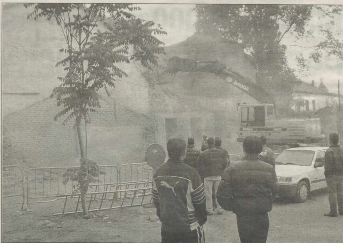
Vecinos y curiosos observan la demolición de uno de los inmuebles declarados en ruina
