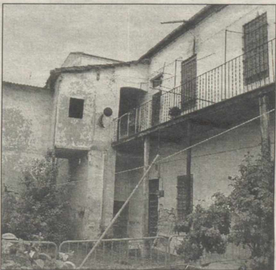
Parte de corrala que será derribada hoy
