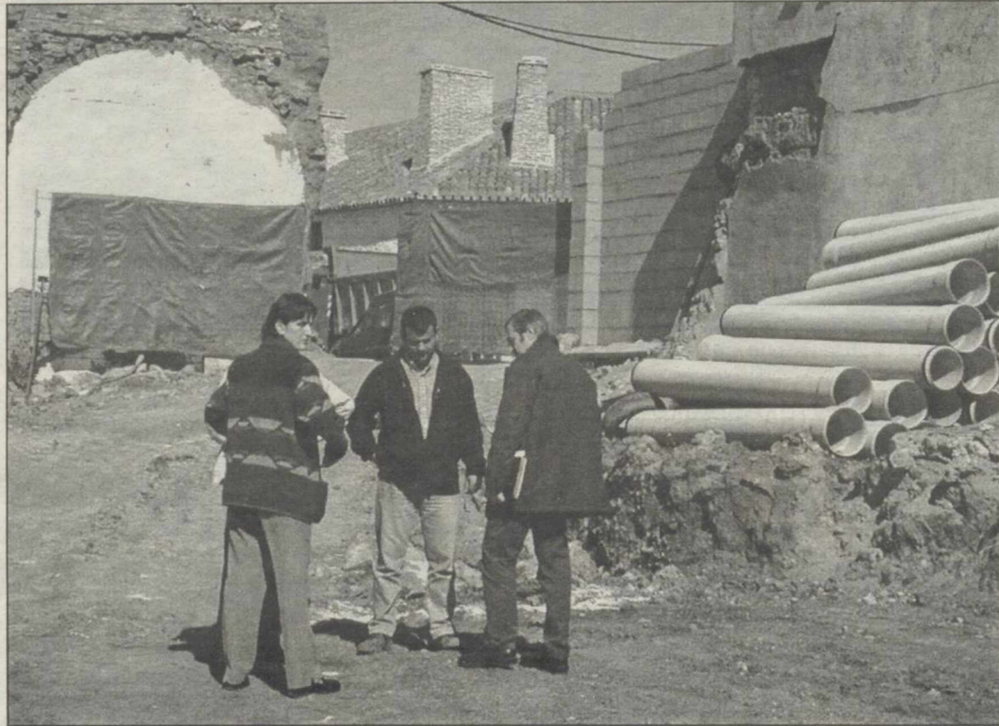
Estado actual que presentan las mencionadas obras
