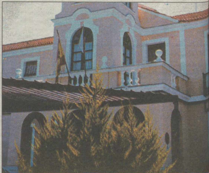
El movimiento sísmico tuvo su epicentro en Malagón
