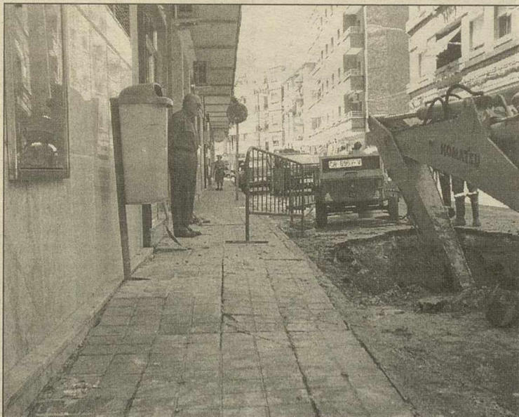
El impacto de la excavadora levantó un poco el acerado Rueda Villaverde
