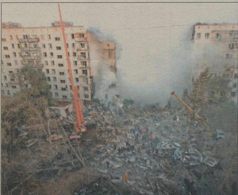
La sección central del edificio quedó derruida.
