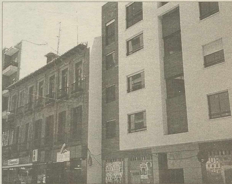
Grupo de viviendas de Ciudad Real.
