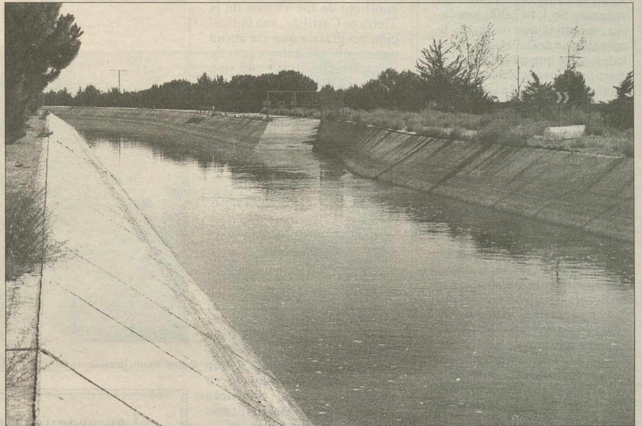
126 hectómetros cúbicos de agua pasarán de nuevo por el acueducto Tajo-Segura.
