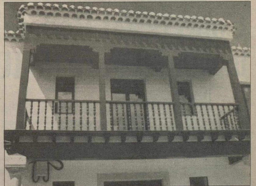
Fachada de la Casa del Agricultor.
