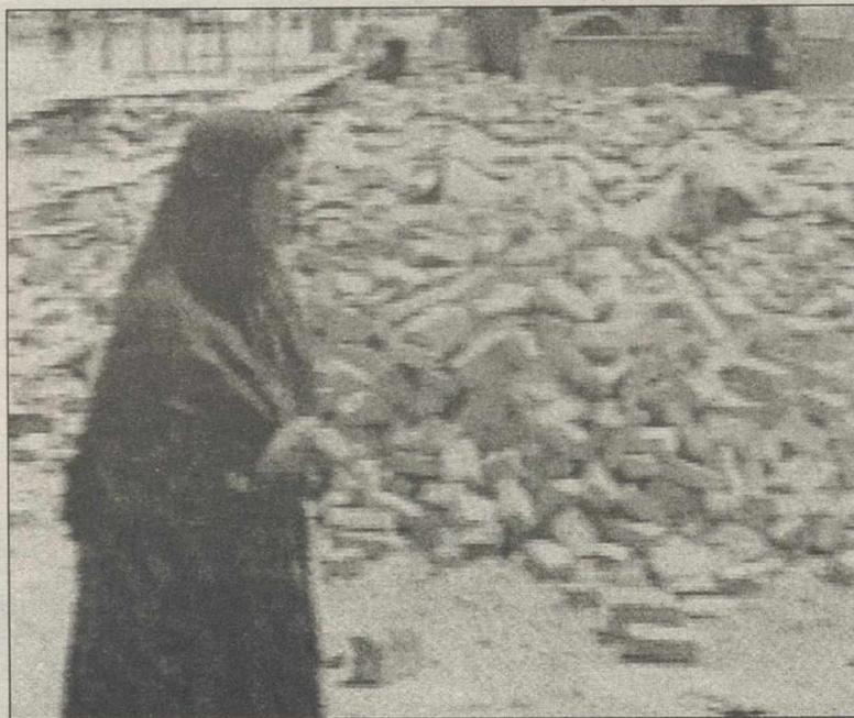
Las aldeas y casas de la zona han quedado destruidas.
