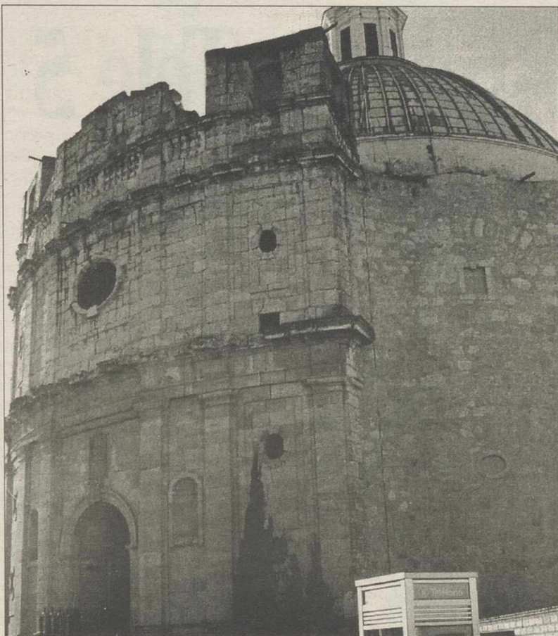
Estado actual de la "Torre gorda" de Miguelturra.
