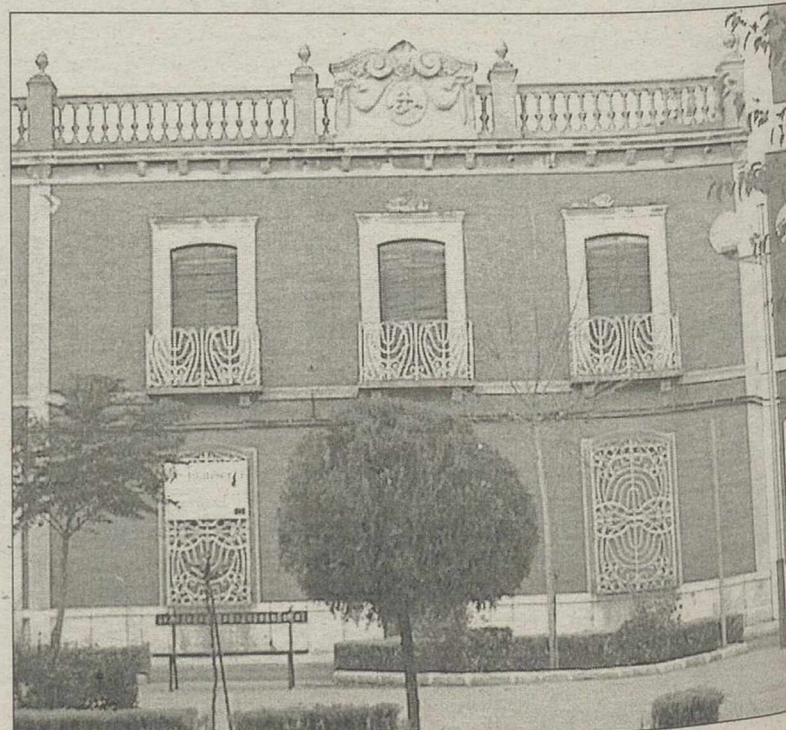
Este edificio acogerá el Centro de Apoyo al Empleo de MANSERJA.
