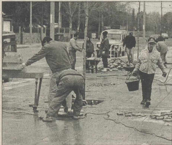
Obras de acondicionamiento del bulevar. T. FERNANDEZ
