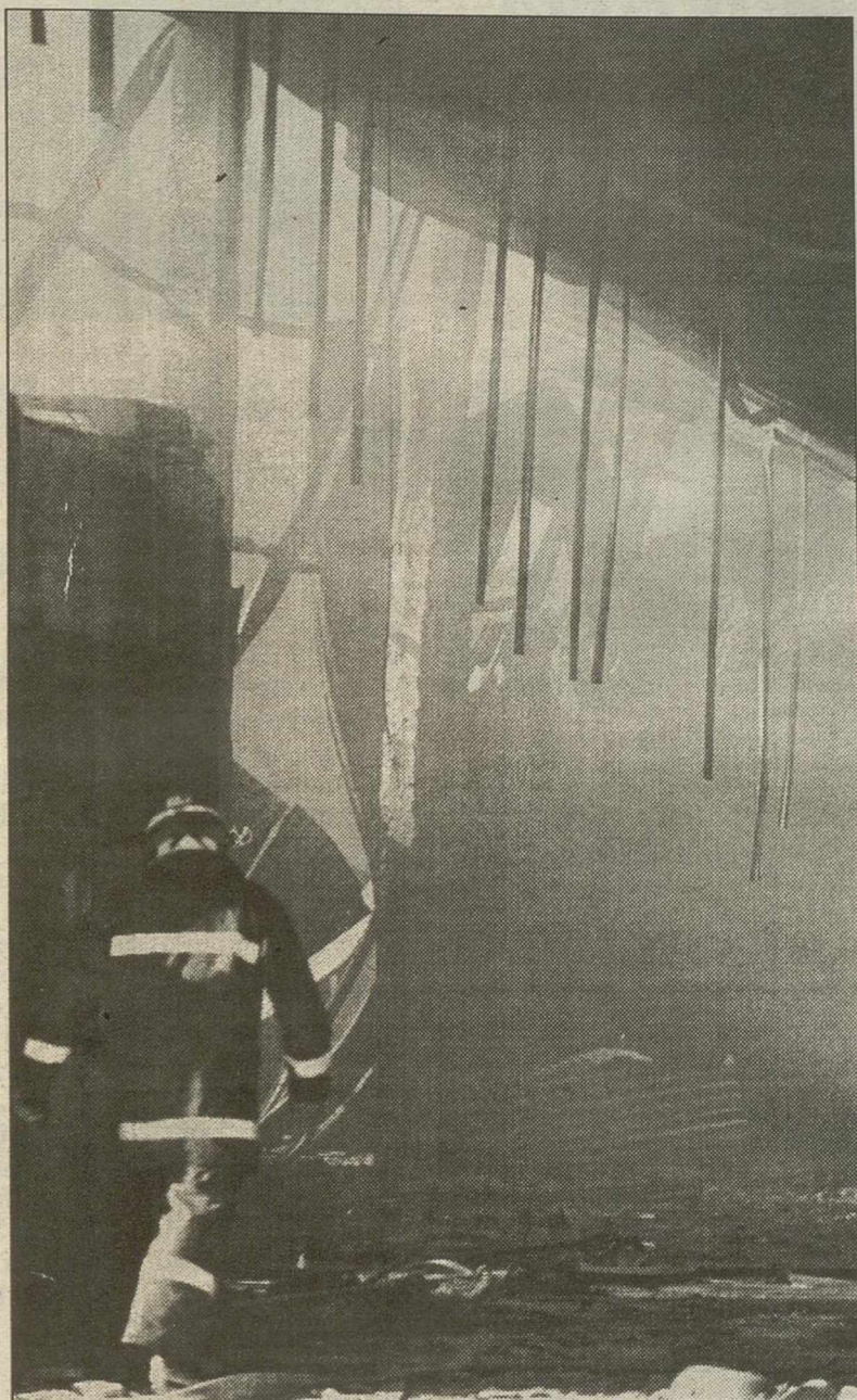
Estado en el que quedó una de las naves incendiadas.
