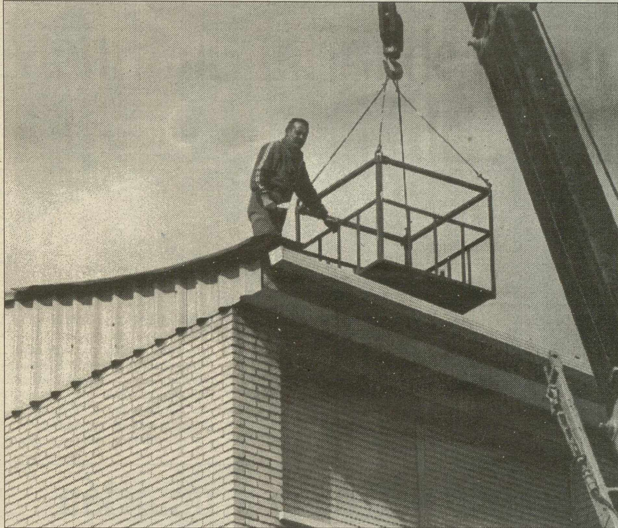
Un trabajador accedió al tejado con una grúa y apretó varios tornillos.
