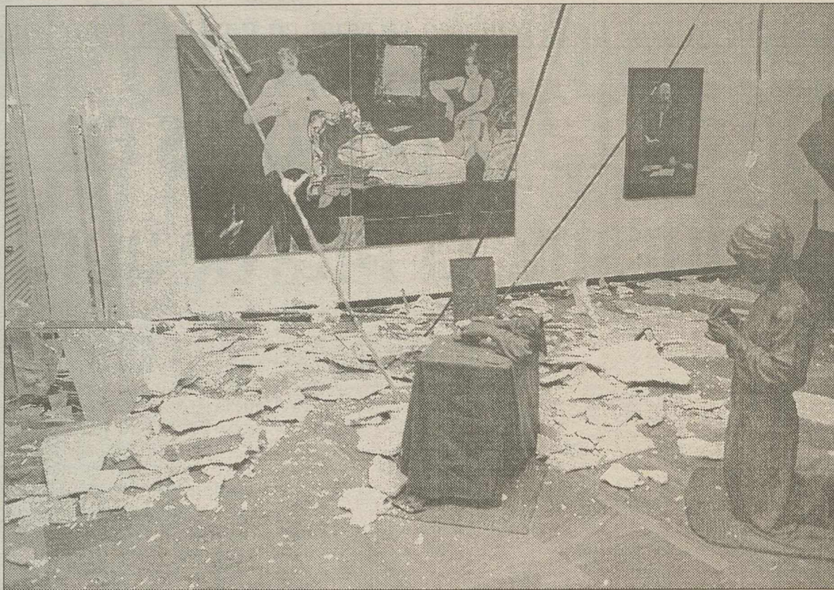
Estado en el que quedó la sala de la segunda planta del Museo tras desplomarse la escayola.
