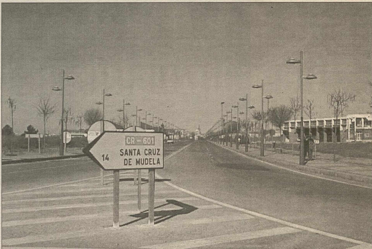
Este es uno de los dos puntos de la circunvalación 412 donde la Junta construirá una rotonda.
