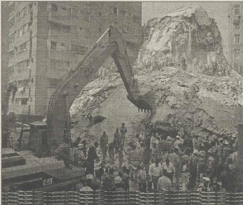
Varias escavadoras despejan la zona siniestrada.
