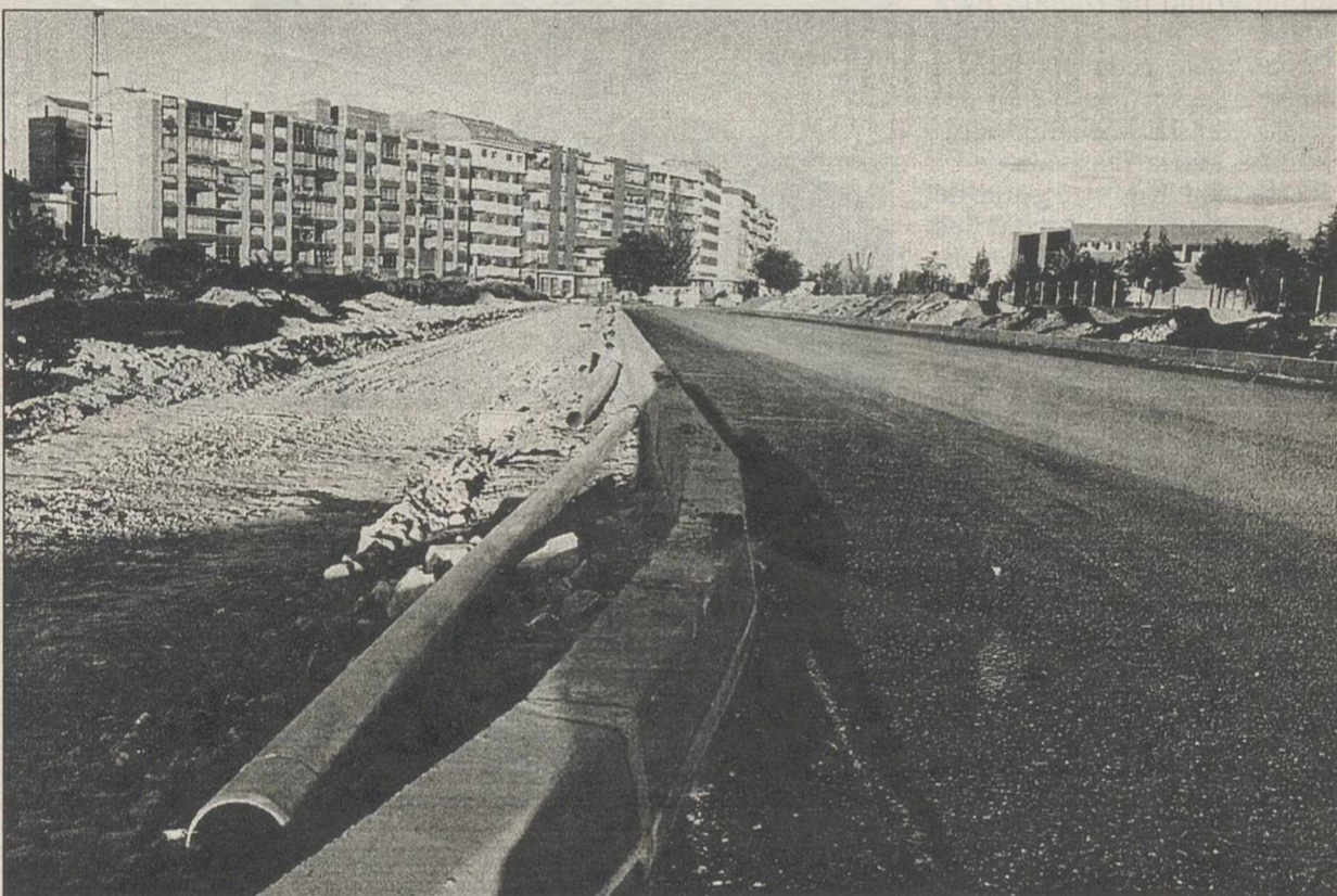
Aspecto que ofrecían ayer parte de los antiguos terrenos de Renfe donde se acometen obras de urbanización. T. F.
