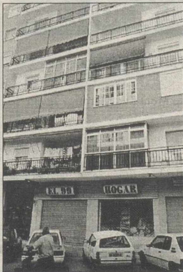
Edificio del que cayó el joven.
