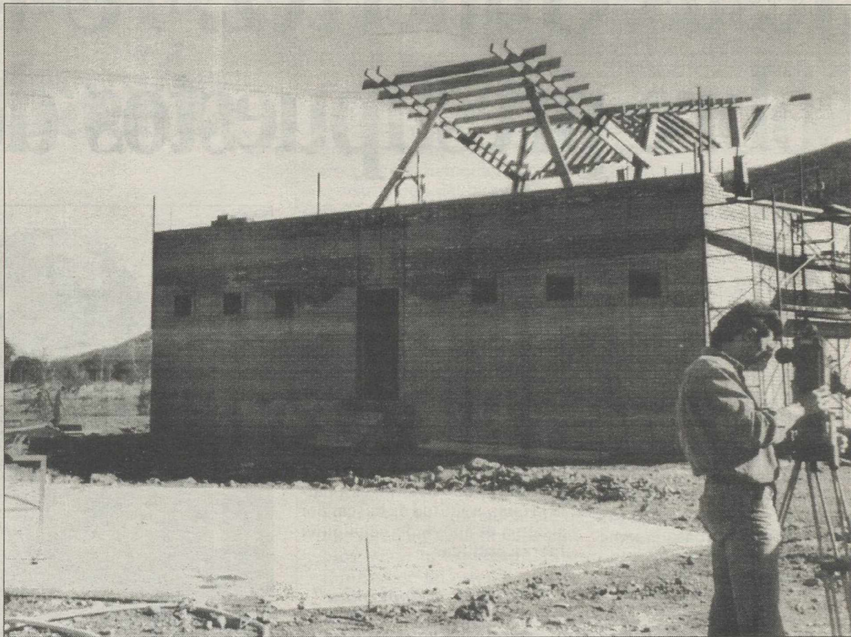
Albañilería y Revestimientos han sido las dos especialidades de los cursos.
