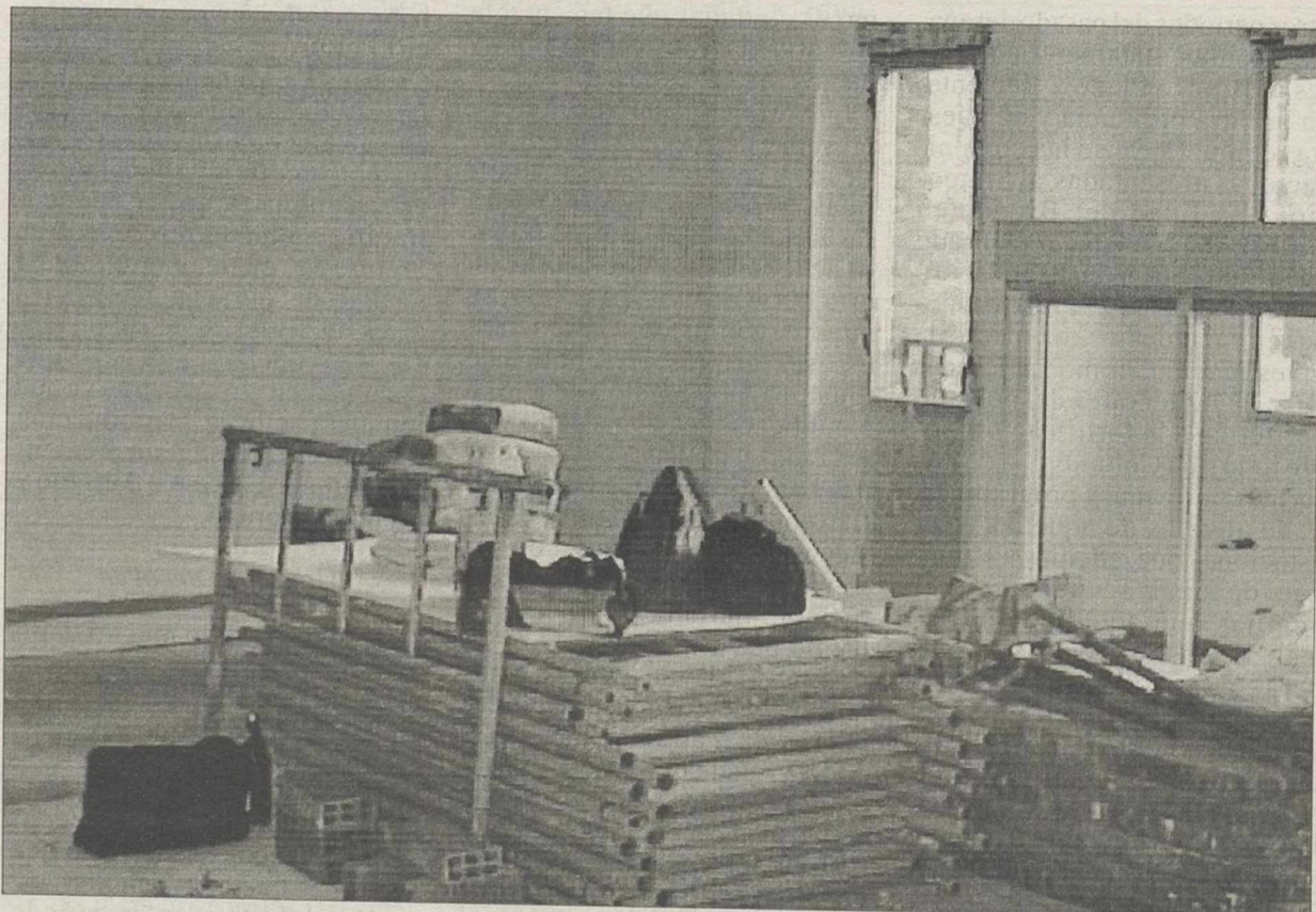
Las obras del nuevo local del CPR avanzan a buen ritmo.
