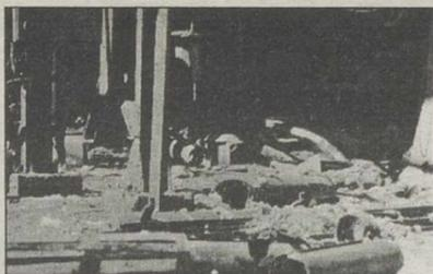
En la apertura de la válvula macho y la válvula automática de bloqueo de gas está la clave sobre el origen humano o técnico del fallo que provocó el accidente
