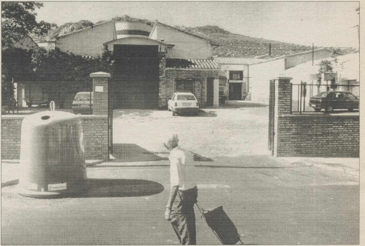
Los mayoristas continúan comprometiéndose a mantener en condiciones de salubridad el antiguo matadero.
