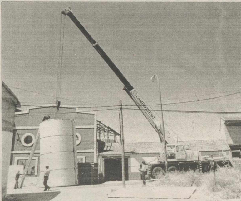
Momento en que estaban colocando uno de los depósitos. T.FERNANDEZ
