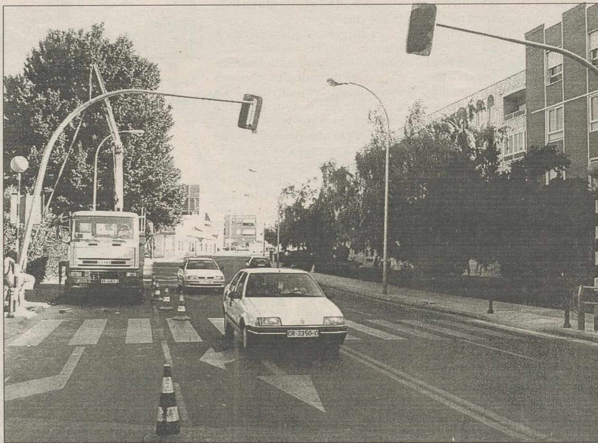
Operarios municipales trabajaban ayer en la instalación del semáforo.
