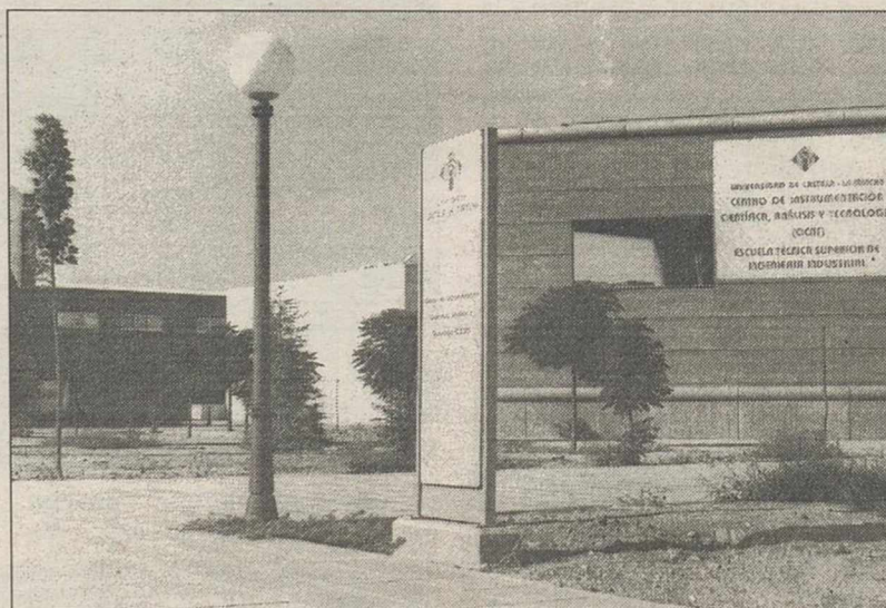
La universidad recibirá unos equipos de acumulación.
