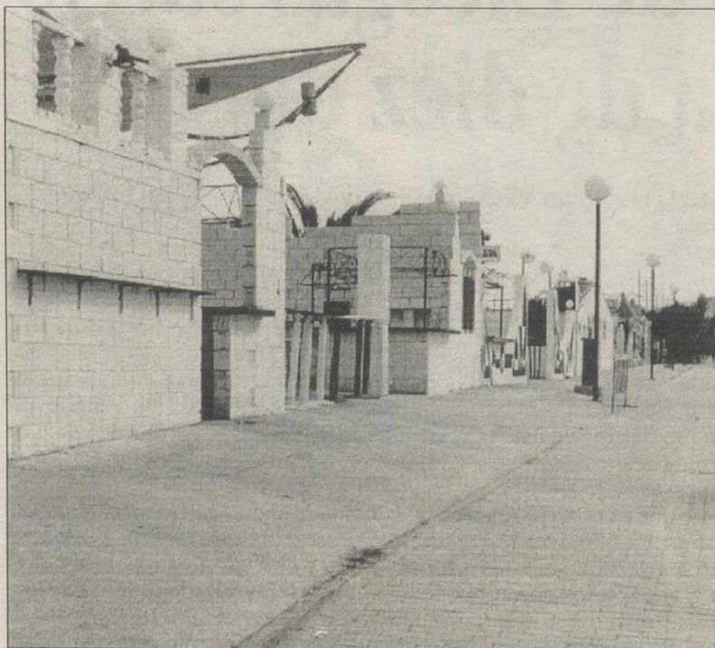
Este año se podrá instalar cuatro chiringuitos.
