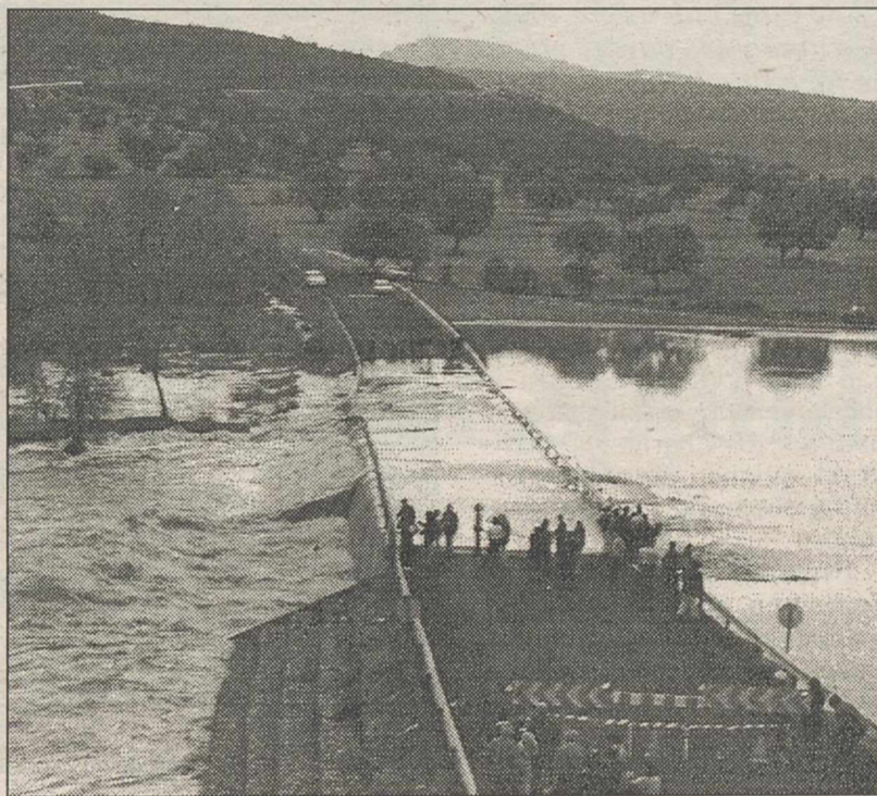
La cuenca del Guadiana ha sido la tercera más dañada.
