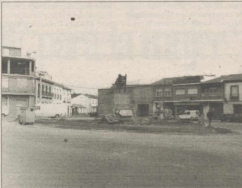
Las obras en la Plaza del Remedio han sido paralizadas.
