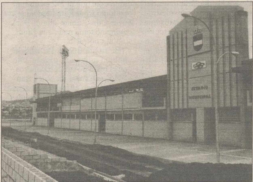
El césped del Fco. Sánchez Menor, afectado por las lluvias.
