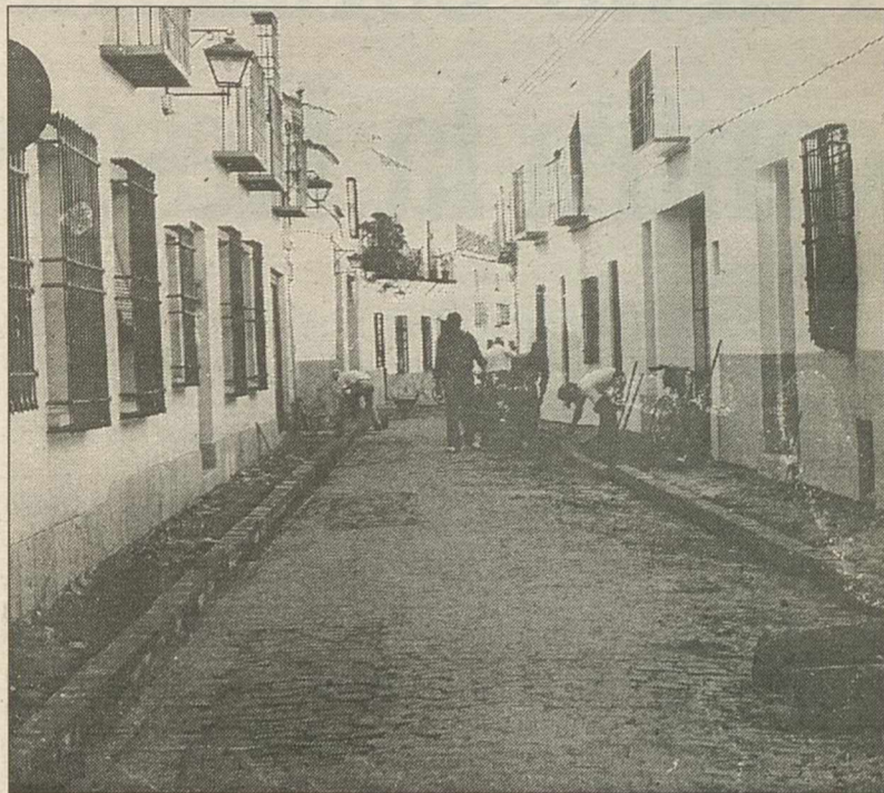
Los trabajadores comenzaron la mejora de acerados el pasado lunes. S.B.
