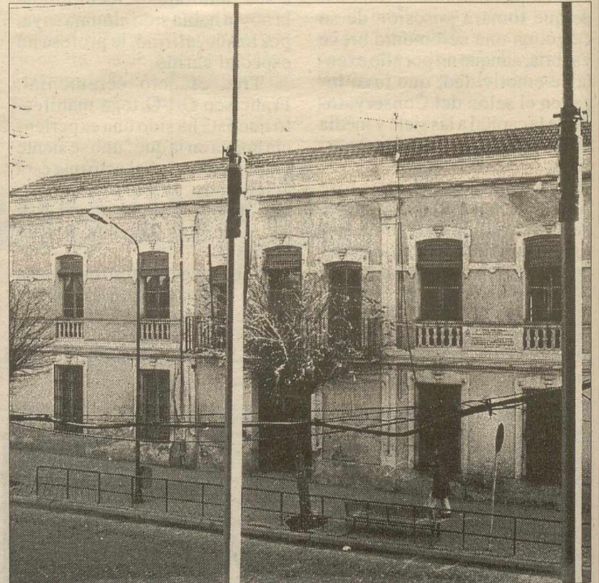
Edificio del Instituto Popular de la Concepción, en la calle de la Mata.
