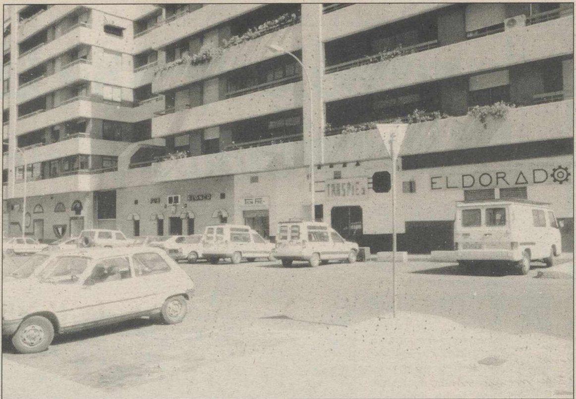
Las obras mejorarán la presión del agua en la zona del Torreón
