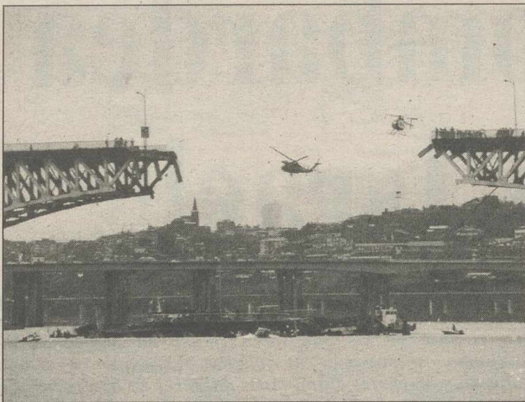
El hundimiento del puente Songsu sobre el río Han causó una tragedia.
