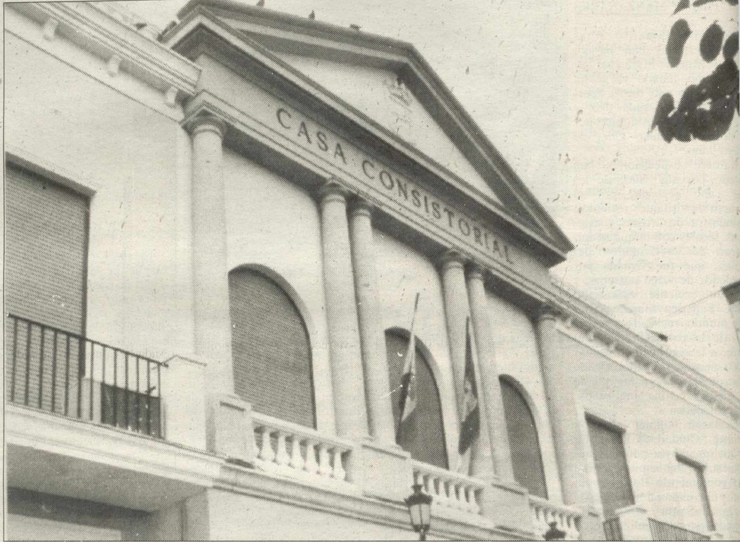
Si el Ayuntamiento admite la denuncia de CCOO sobre prevaricación y cohecho en la cesión de suelo público para construir el centro geriátrico, Camansar lo construirá en otro lugar
